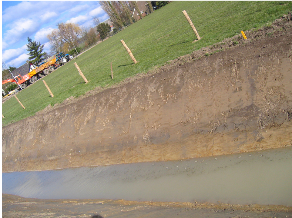
Afbeelding 6.3 Het noordprofiel van de bermsloot met de bewoningslaag zichtbaar als donkere baan. Foto: S.J. Tuinstra.
