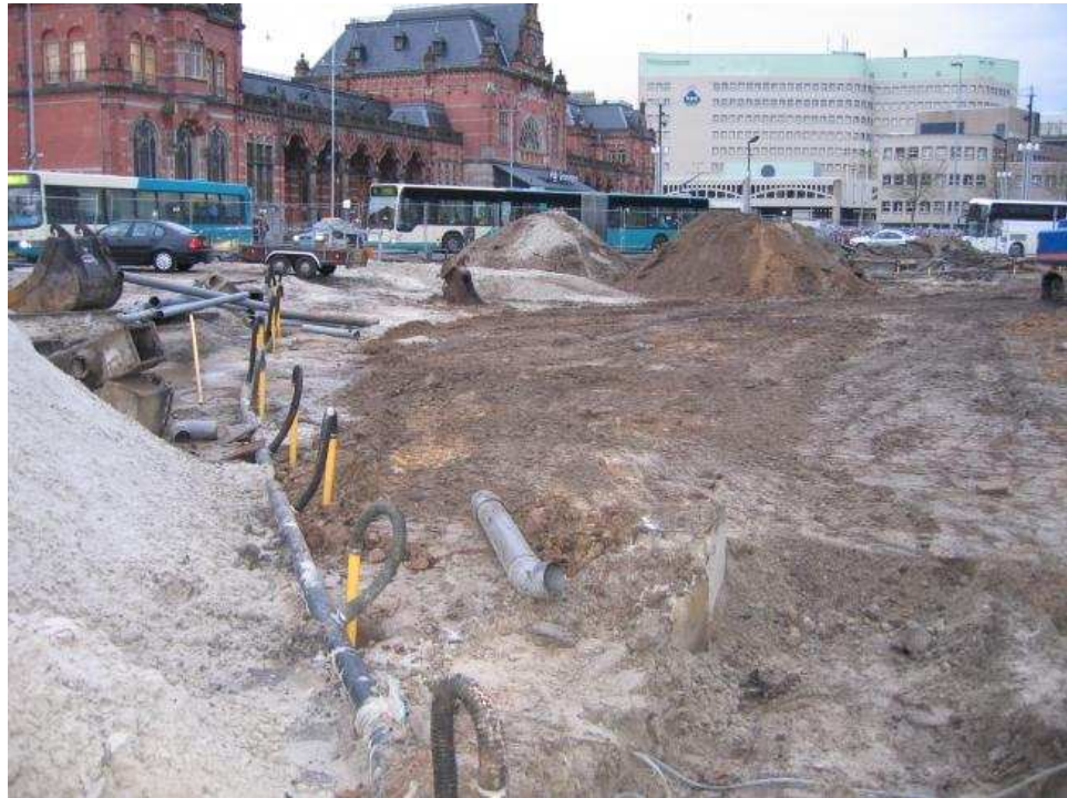
Afbeelding 1.2 Het plein voor aanvang van de graafwerkzaamheden. Foto J. Y. Huis in 't Veld.
