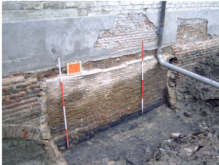
Afbeelding 2.6 De achtermuur van de waterkelder in de Abdijmuur gezet. Foto: J.M. Pasveer.
