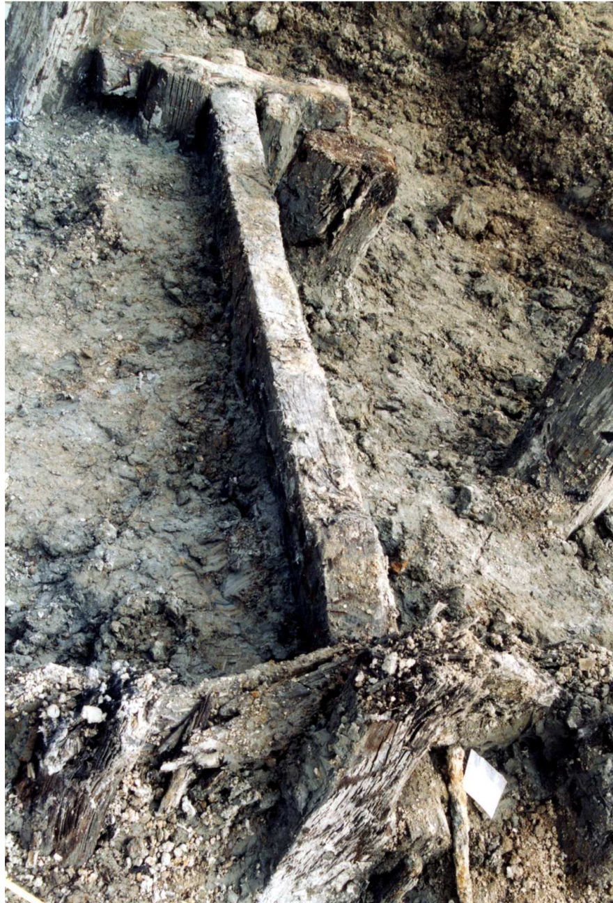
Afbeelding 2.3 De trekbalk en de metalen pen waarmee hij was bevestigd aan de beschoeiing. Foto: A. Ufkes.
