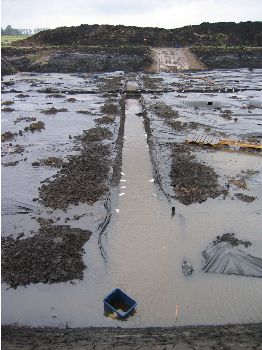
Afbeelding 1.5 Overzicht van de met landbouwplastic afgedekte bouwput na heftige regenbuien. Foto: J.R. Veldhuis.
