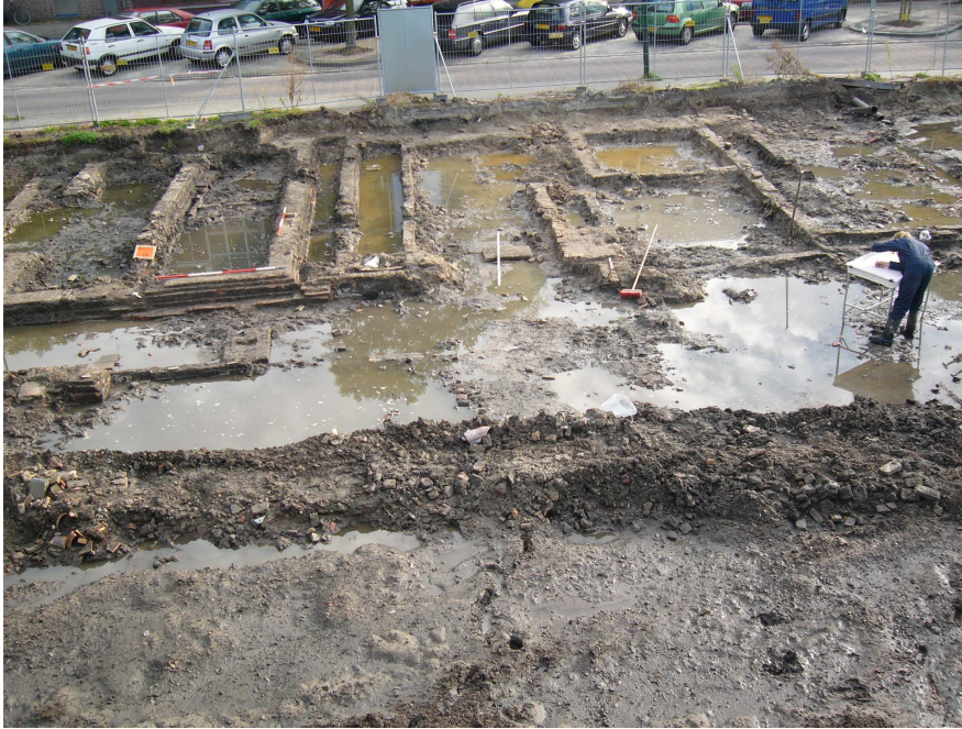
Afbeelding 2.4 Overzicht van de funderingen langs de Raam op vlak 2. De regenval en hoge grondwaterstand maakt het documenteren moeilijk. Foto: B. Silkens.
