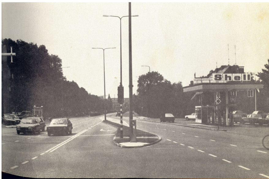
Afbeelding 2.5 Op deze foto uit 1982 zijn twee Shell-stations zichtbaar. Eén rechts op de voorgrond, tegenover de onderzoekslocatie en één links op de achtergrond op de locatie van het toekomstige bergbezinkbassin. Bron: Dhr. J. Wijnen.
