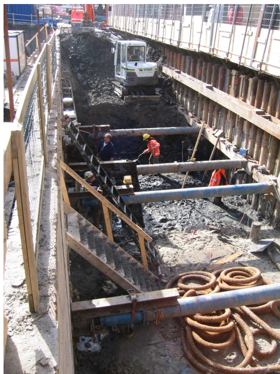
Afbeelding 1.5 Overzicht van de werkzaamheden in de bouwput. Foto: J.Y. Huis in 't Veld.
