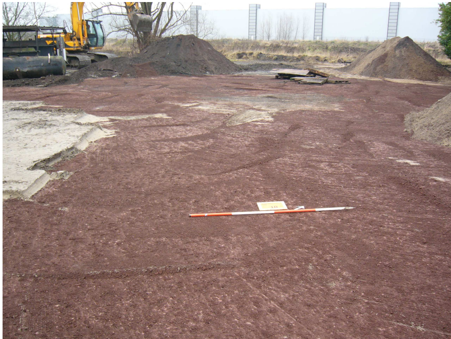
Afbeelding 2.5 Grindlaag onder de voormalige parkeerplaats. Foto: H. Halici.
