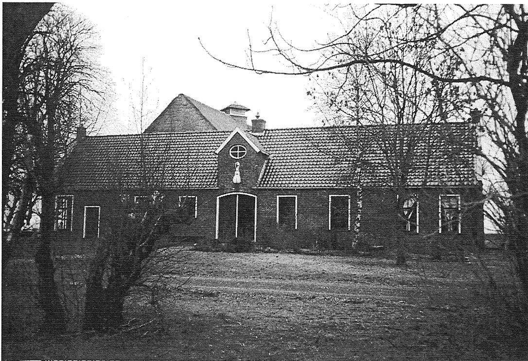
Afb. 8: Het oostelijk schathuis in zijn huidige staat
