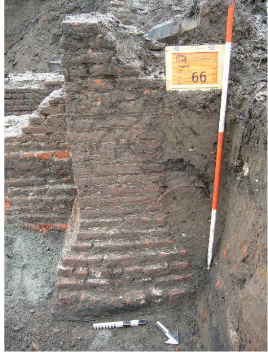
Afbeelding 2.44 Het zware fundament van de keermuur van de toegangstunnel tot de kazemat. Foto: G.J. de Roller.
