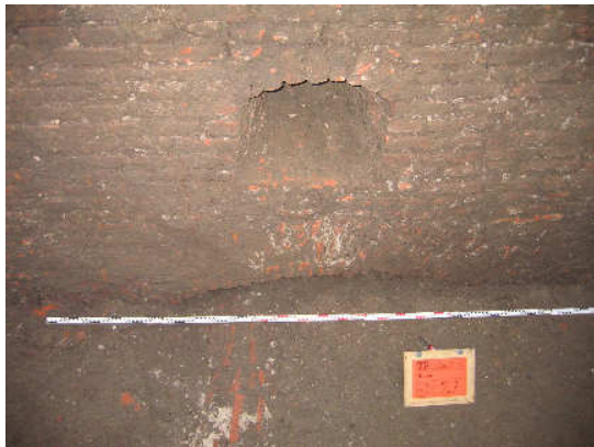
Afbeelding 2.3 Rollaag van de segmentboog aan de binnenzijde van de Kornemuur. Foto: G.J. de Roller.
