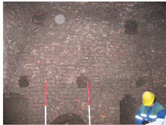
Afbeelding 2.29 De bovenste rij steigersgaten met de gaten aan de basis van de koepel. Foto: G.J. de Roller.
