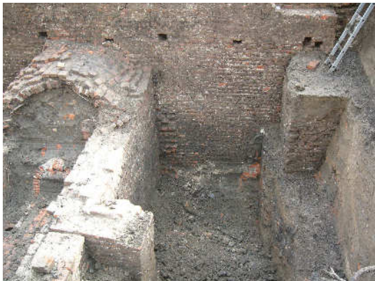
Afbeelding 2.45 De steunbeer, rechts bij de trap, bij de aanhechting van kazemat en stadsmuur Foto: G.J. de Roller.
