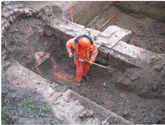
Afbeelding 2.43 De keermuur van het eerste tunnelsegment. Foto: M. Defilet.
