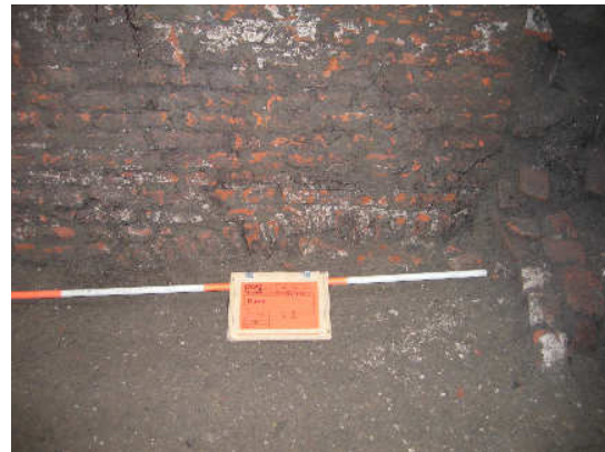
Afbeelding 2.4 Rollaag van de segmentboog aan de binnenzijde van de straatmuur. Foto: G.J. de Roller.
