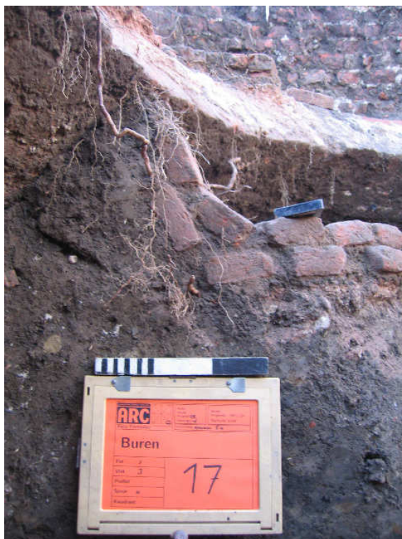
Afbeelding 2.32 Ten gevolge van het nazakken van de vulling in de kazemat, zijn de stenen aan de rand van de koepel blijven hangen. Foto: G.J. de Roller.
