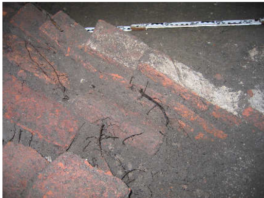
Afbeelding 2.24 De opbouw van de wand van het riool. Foto: G.J. de Roller.
