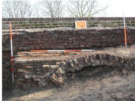
Afbeelding 2.48 De spaarboog van de stadsmuur. Foto: M. Defilet.
