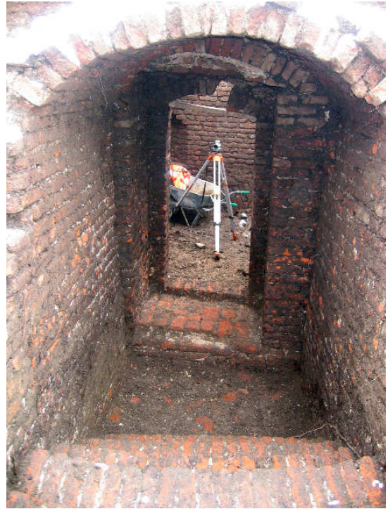
Afbeelding 2.19 Deuropening van de buitenkant. Foto: G.J. de Roller
