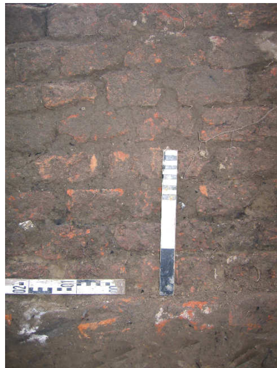
Afbeelding 2.38 Aanzicht van de muur (spoor 18) met de verschillende steenmaten. Foto: G.J. de Roller.
