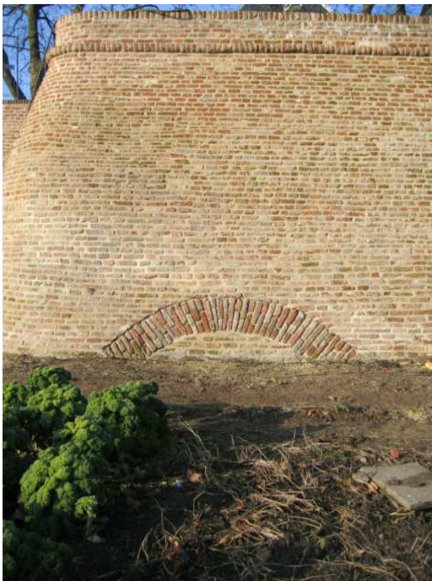
Afbeelding 1.11 De segmentboog aan de buitenkant van de stadsmuur op de opgravingslocatie. Foto: G.J. de Roller.
