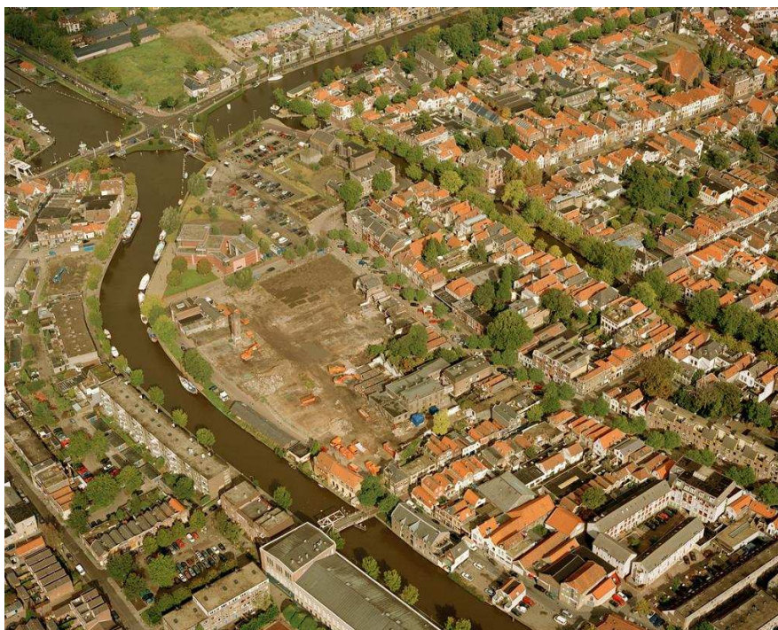
Afbeelding 1.3 Overzicht van de Koningshoflocatie op een luchtfoto genomen tijdens de sloopwerkzaamheden. Bron: Soelaas milieu-adviezen bv.
