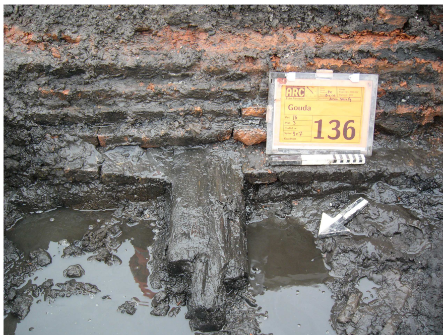
Afbeelding 2.6 Werkput 16. Detail van een houten funderingsbalk. Het bewerkte uiteinde wijst mogelijk op herbruik. Foto: B. Silkens.
