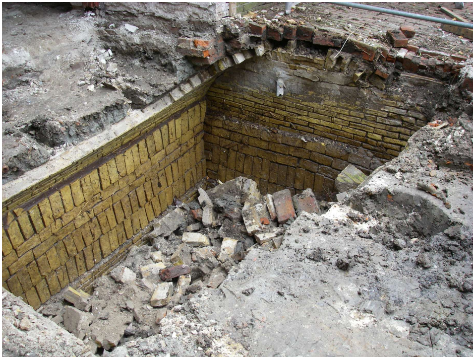
Afbeelding 2.5 Waterkelder na verwijderen tongewelf. Foto: A. Wieringa.
