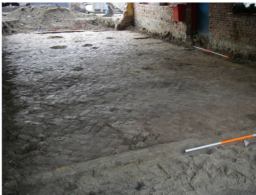
Afbeelding 2.6. Loodkamer, vlak 3: vloer van rode handgevormde baksteen in visgraatpatroon (s16).
