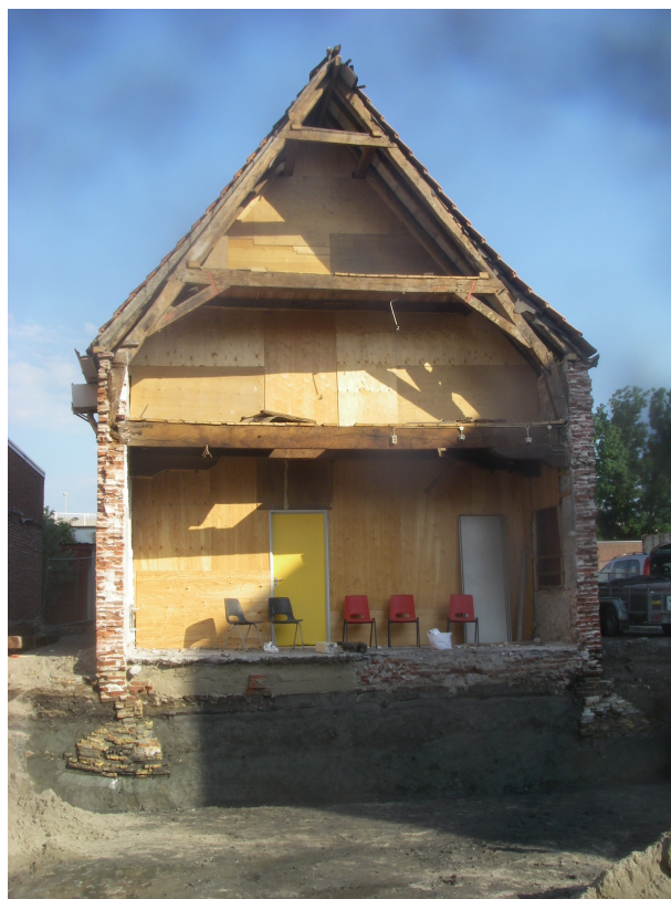
Afbeelding 12.1. Fundering van het arsenaal.
