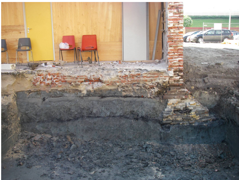
Afbeelding 2.2. Zuidelijke fundering van de buitenmuur van het arsenaal.
