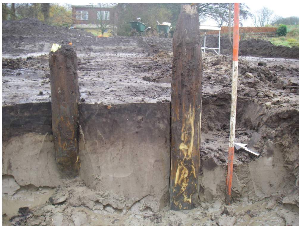
Afbeelding 3.9. Werkput 7: Ingeslagen brugpalen (s26 en s31).
