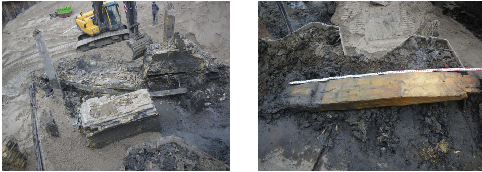
Afbeelding 3.1. Werkput 3: Houten fundering onder de muur en een bewerkte houten paal. Foto's: B. Huizenga.
