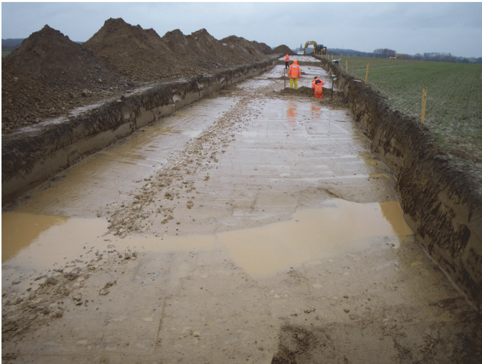
Fig. 3.2: Vlakaanleg en spoorbewerking in werkput 43.
