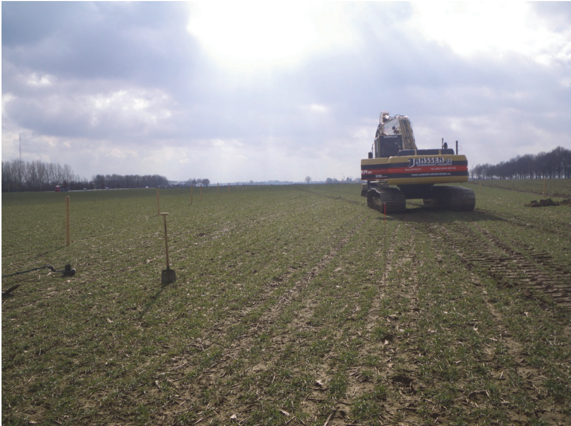
Fig. 1.2: Het plangebied op de eerste dag van de werkzaamheden.
