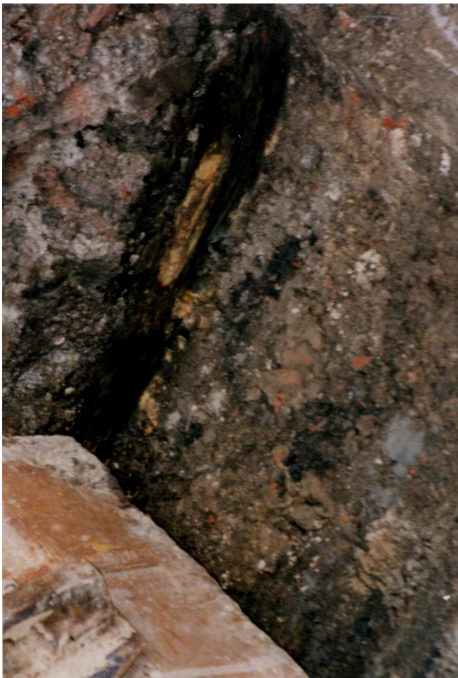
Foto 1: In de lengte liggende balk wordt door de bak van de kraan geraakt. Hieronder zijn de kopse einden van de dwarsliggende balkjes te zien. Foto Boarnstra.
