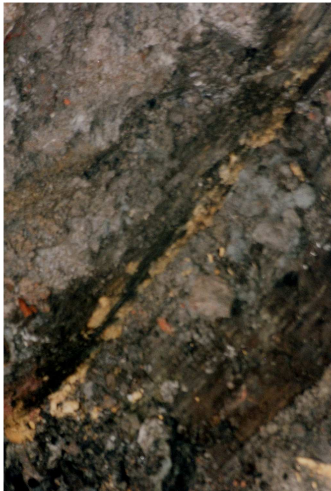
Foto 2: Kopse einden van de onderliggende balklaag is goed te zien. Bovenliggende balk is net geraakt. Foto Boarnstra.
