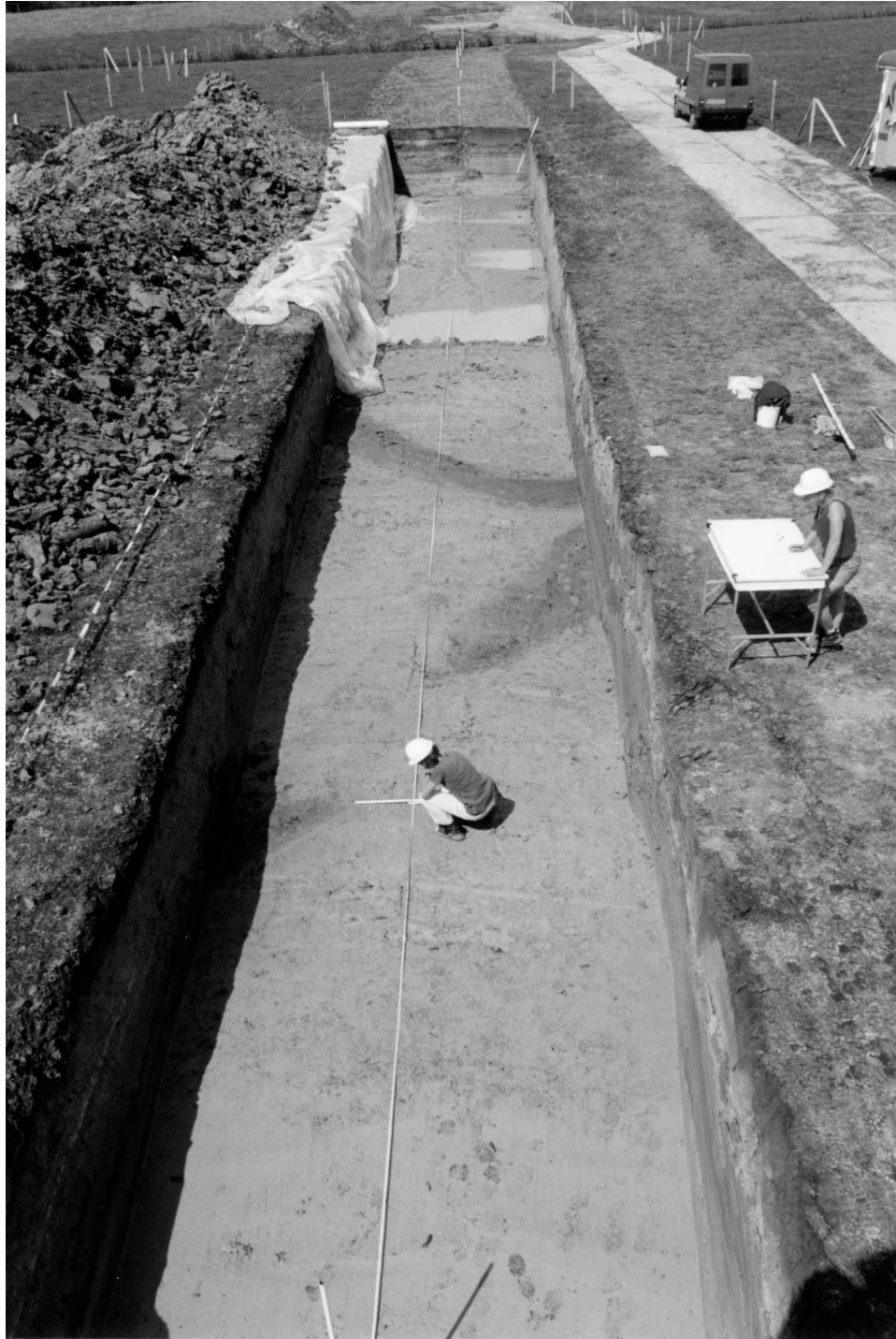
Afbeelding 2.2 Werkzaamheden in de sleuf, Allengastate; foto Y. Dijkstra.
