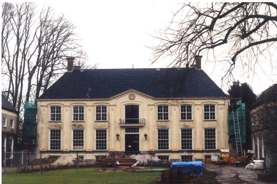
Afbeelding 4. De huidige voorgevel (foto ARC bv).
