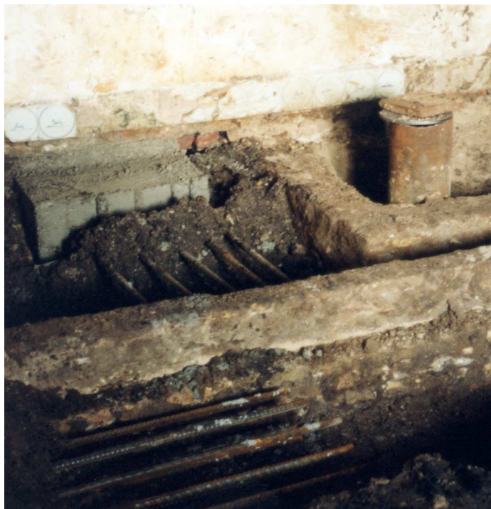
Afbeelding 5. Een betonstiep in ruimte N (foto ARC bv).
