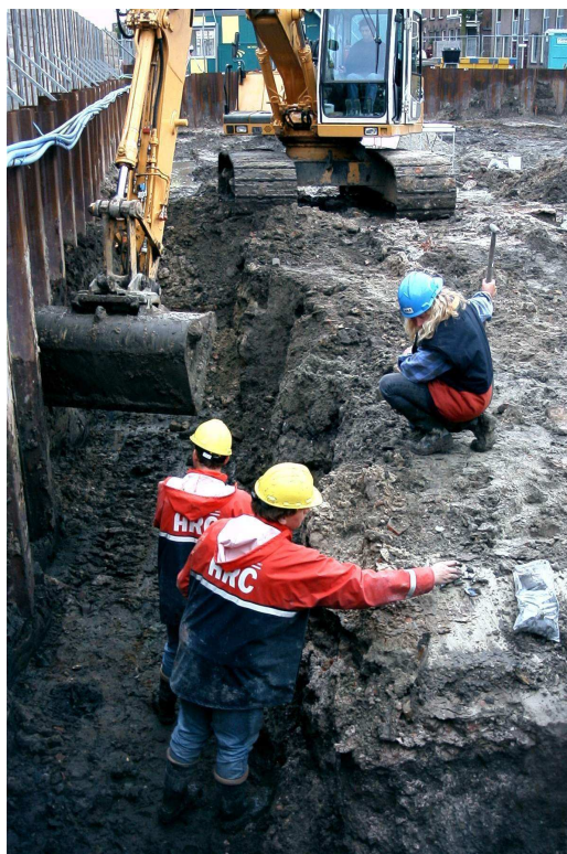
Afbeelding 1.5 Aanleg van de ringdrainage, foto L. de Jong.
