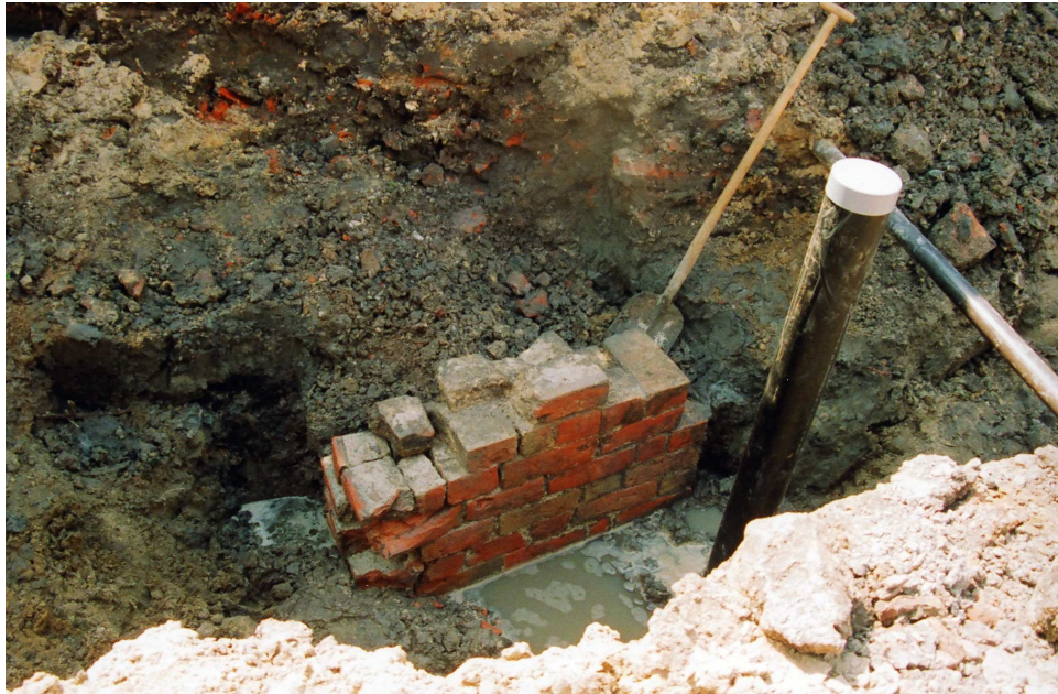
Afbeelding 2.8 Kleine funderingsstiep in de Kapeldwarsstraat; foto M. Huisman.
