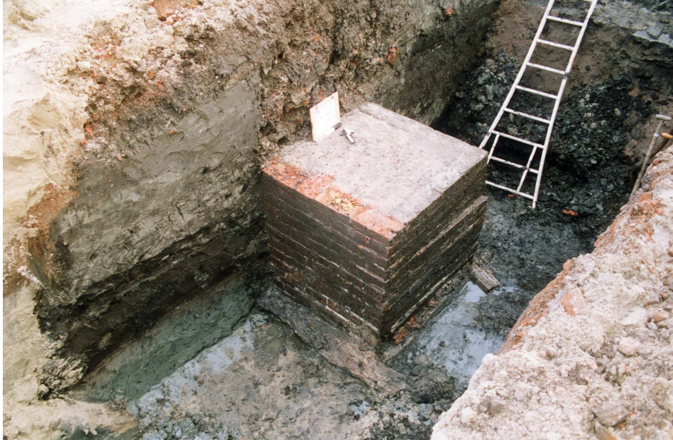
Afbeelding 2.4 Westelijke funderingsstiep; foto C.G. Koopstra.
