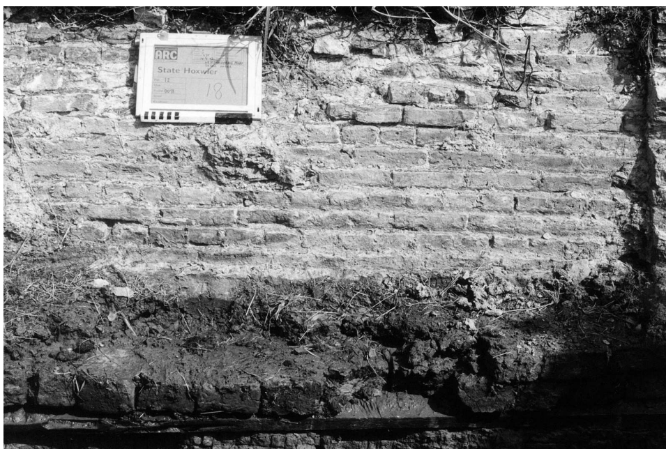
Afbeelding 2.7 De fundering van de dam, bestaande uit een grenen plank en een laag kloostermoppen. Foto S.J. Tuinstra.
