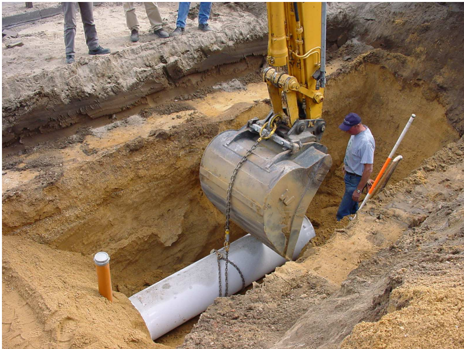
Afbeelding 4 Plaatsen van een nieuwe rioolbuis in de Generaal Foulkesweg. Foto: M. Essink.
