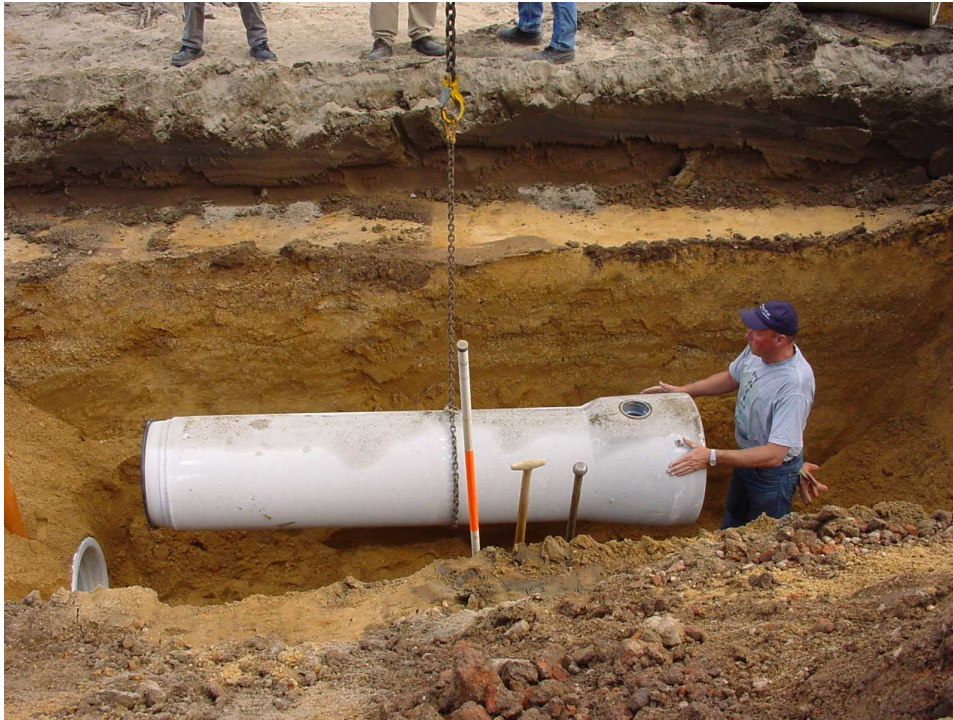
Afbeelding 3 Laten zakken van een nieuwe rioolbuis in de sleuf in de Generaal Foulkesweg. Foto: M. Essink.
