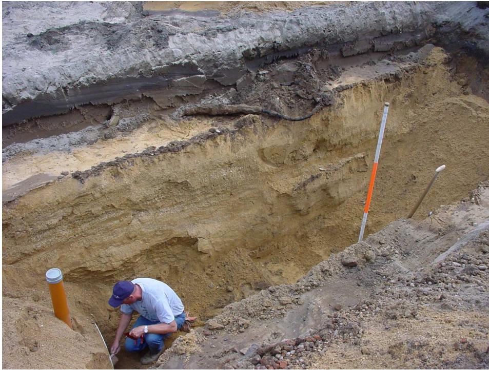
Afbeelding 5 Profiel bodemopbouw in de rioolsleuf in de Generaal Foulkesweg. Foto: M. Essink.
