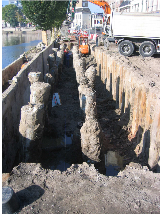
Afbeelding 4 Overzicht van bouwput 1. Foto: G.J. de Roller.
