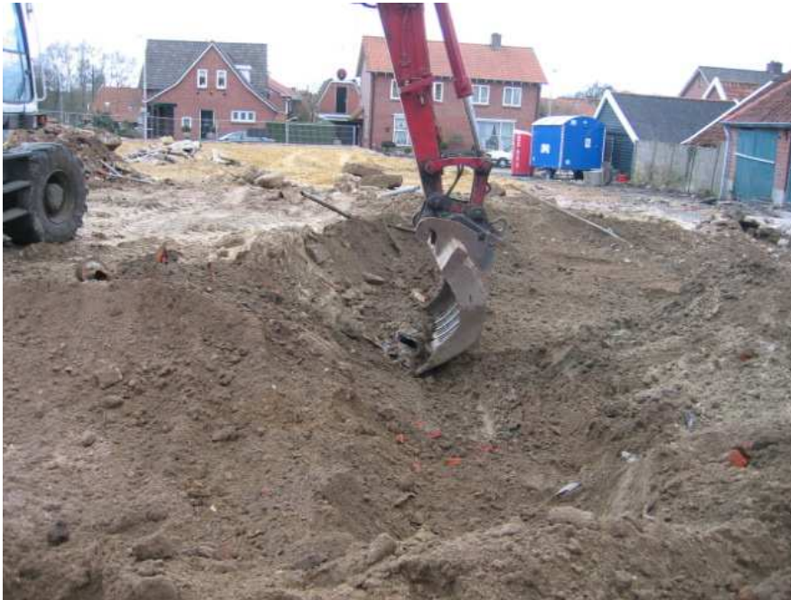
Afbeelding 4 Machinale sloop van bestaande funderingen. Foto: G.M.A. Bergsma.
