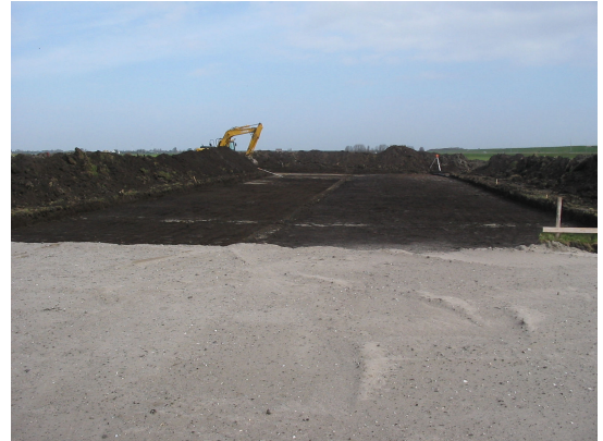
Afbeelding 7 Overzicht van het afgraven van de toplaag, aansluitend aan het zandbed. Foto: M.C. Botermans.
