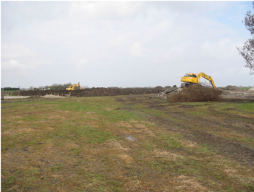
Afbeelding 5 Overzicht van de ontgronding en sloop van de voormalige boerenschuur. Foto: M.C. Botermans.
