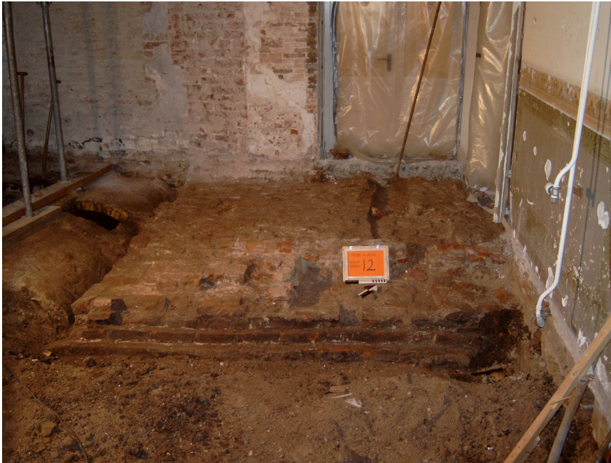
Afbeelding 6 Het blootgelegde fundament van de traptoren. Foto: S.J. Tuinstra.
