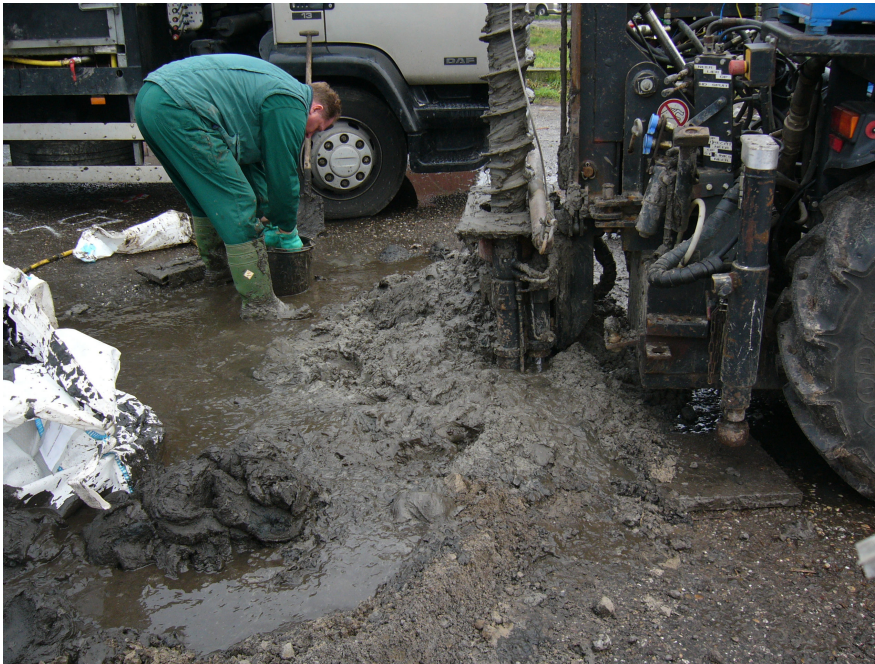
Afbeelding 4 Het gebruik van een mechanische boor met holle avegaren. Foto: B. Silkens.
