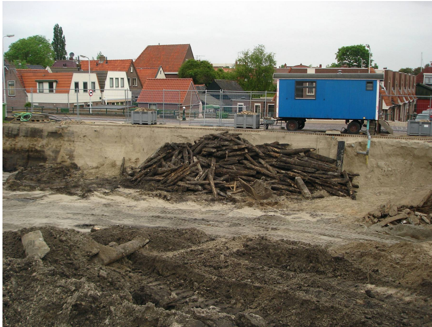
Afbeelding 4 De door de aannemer verwijderde palen. Foto: P. v.d. Brandt.
