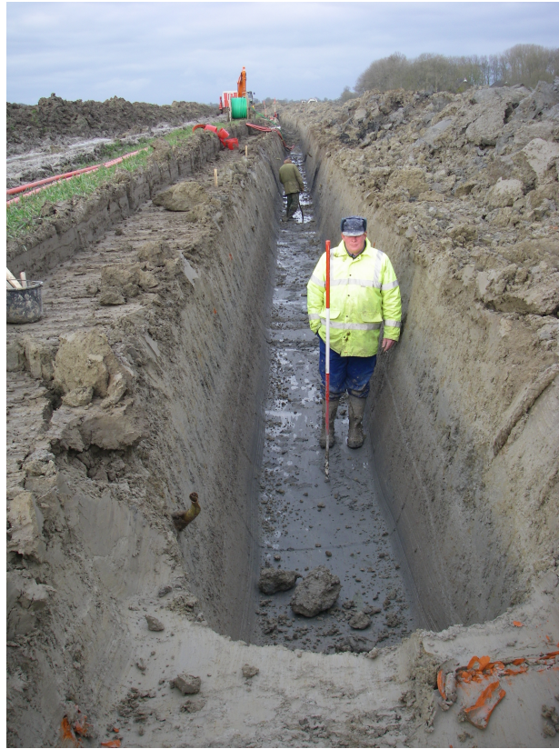
Afbeelding 2. Mansdiep gegraven kabelsleuf.
