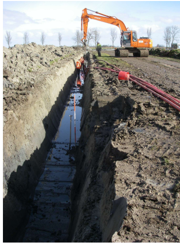
Afbeelding 3. Aanleg van de drie 110kV kabels.
