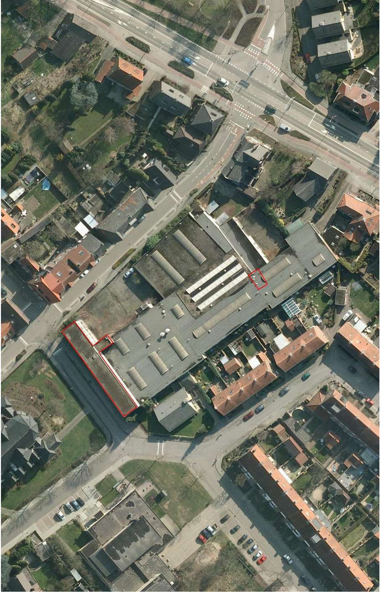
Afbeelding 9. Ligging van de kelders (rood omlijnd) op de onderzoekslocatie. Bron: gemeente Venlo
