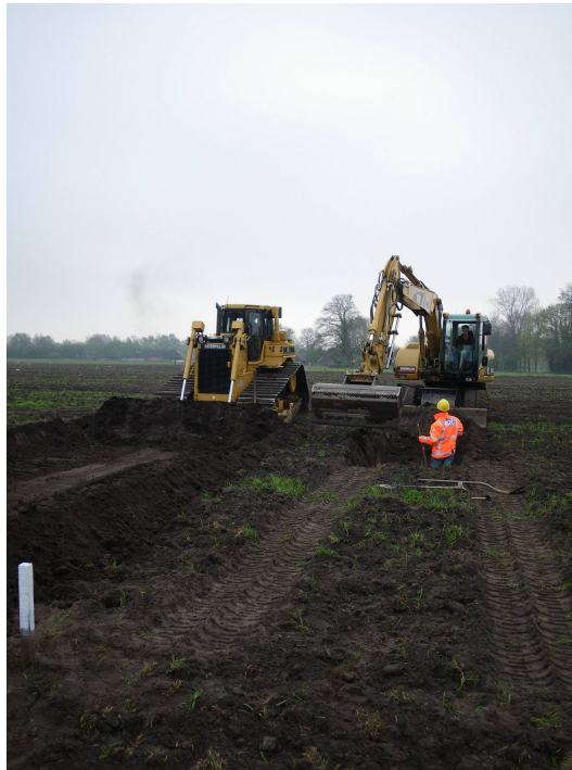
Afbeelding 2. De bovengrond is verwijderd met een bulldozer; de archeologische werkputten zijn wel aangelegd met een graafmachine.
