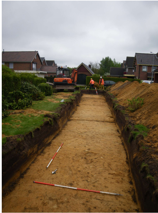
Afbeelding 4. Situatie tijdens de aanleg van de proefsleuf. Werkput 2.
