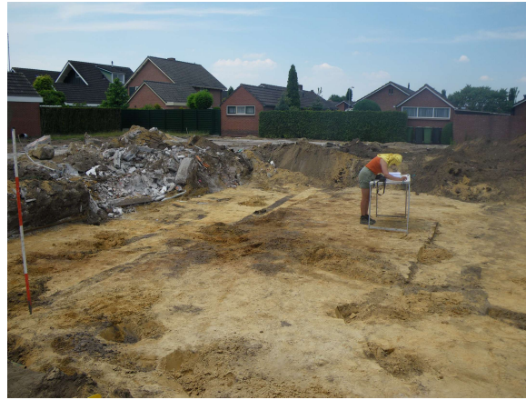
Afbeelding 6. Werkput 3: begeleiding en sloop fundering.
