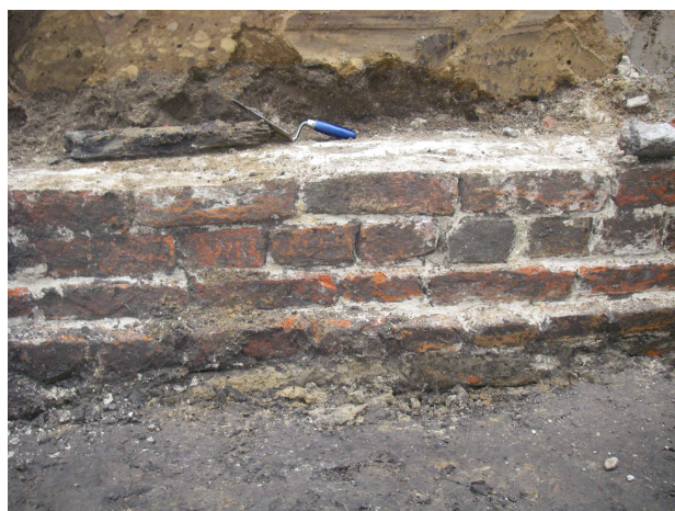
Afbeelding 12. Vooraanzicht van de in schelpkalk gemetselde muur. Foto: gemeente Groningen
