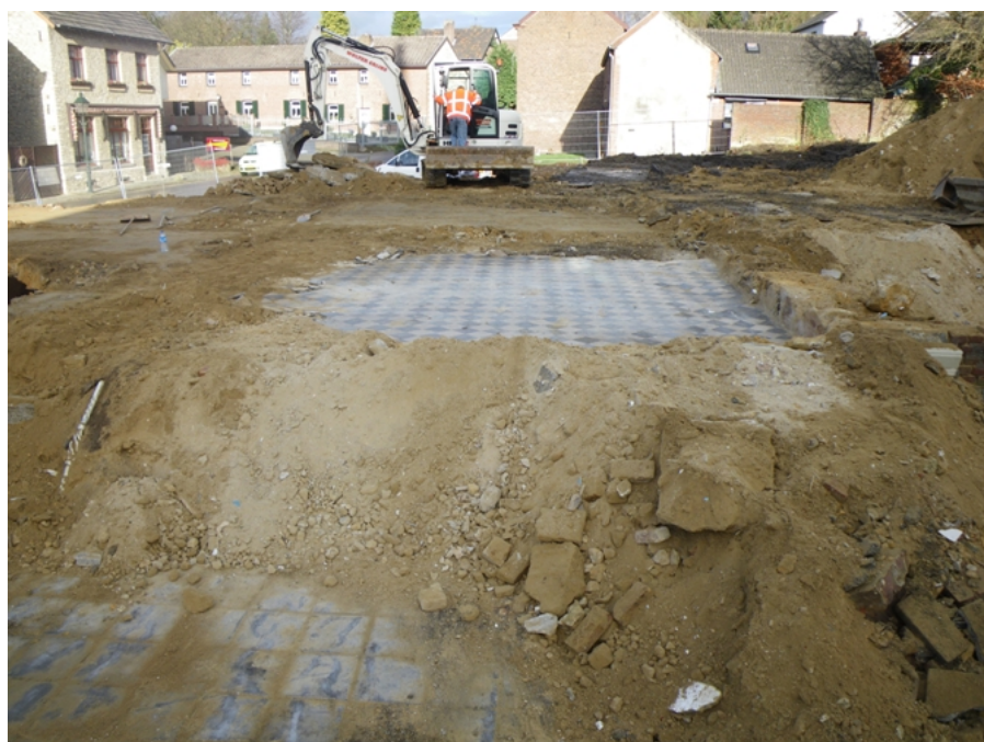
Afbeelding 6. De tijdens de sloopbegeleiding op de onderzoekslocatie aangetroffen tegelvloeren.
