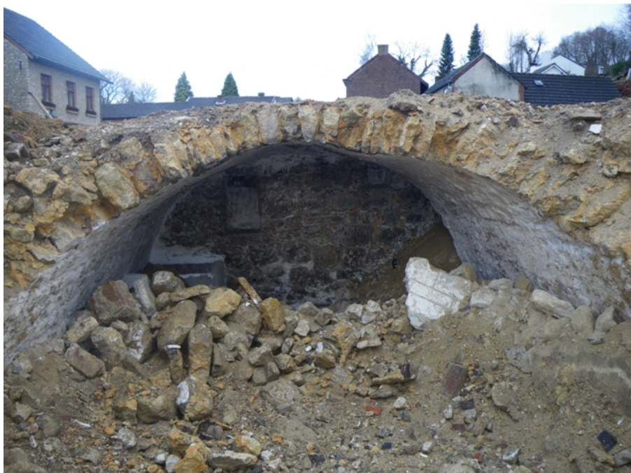
Afbeelding 5. Sloopbegeleiding: de deels ingestorte 17e-eeuwse kelder.
