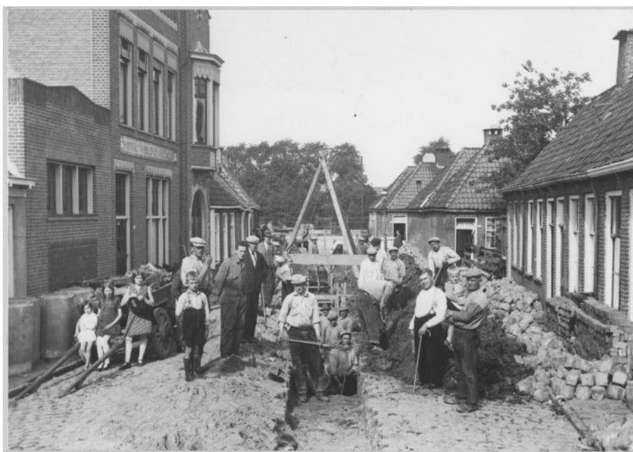
Afbeelding 19. De Walstraat in 1926. Aanleg van het riool. Van de woningen uiterst rechts werd de geheide houten fundering gevonden. Foto: Collectie RHC Groninger Archieven.
