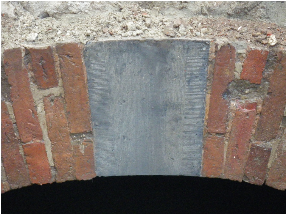
Afbeelding 16. De sluitsteen in de boogconstructie.
