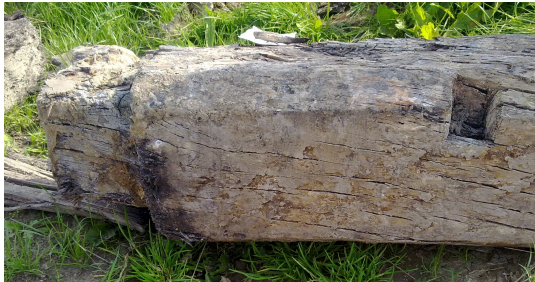
Houtnr 036, vierkant gekapt, lengte 165 m, doorsnede 20 cm. In detail een bewerkingspoor bestaande uit een grote pen ten behoeve van een haakse verbinding en een kleine inkeping.
