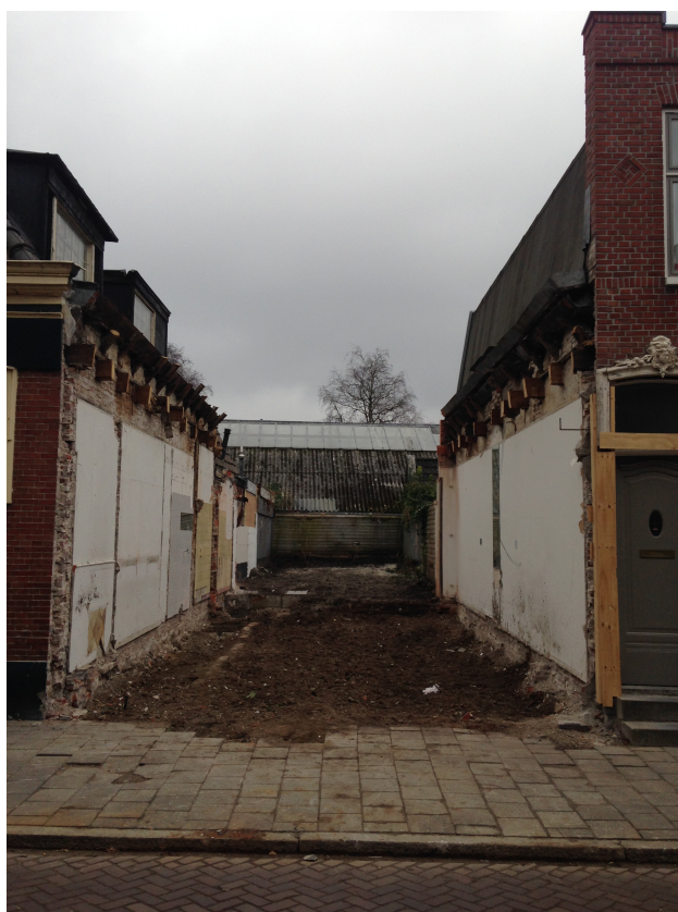
Afbeelding 2. Huidige situatie van Kijk in't Jatstraat 61.
