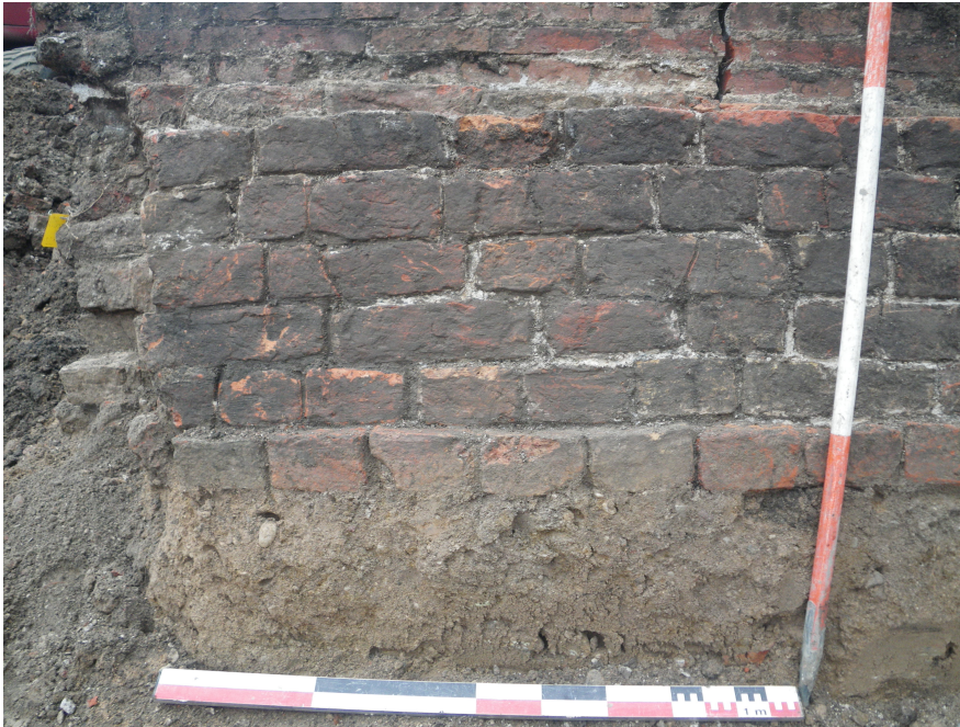
Afbeelding 2.3. Spoor 8: de oostmuur van het achterhuis van pand 24.
